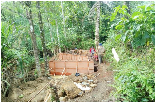
Gambar 9. Pemasangan mal coran
