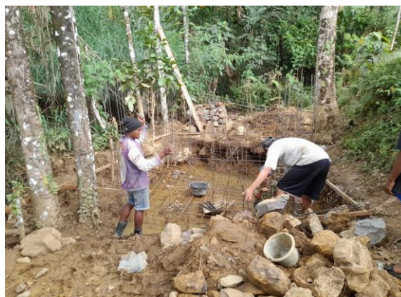
Gambar 10. Pemasangan pondasi
