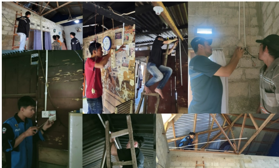
Gambar 4. Tim pelaksana sedang melakukan pemasangan instalasi listrik di rumah warga Pada gambar 4 terlihat tim pelaksanan pengabdian sedang melakukan perawatan, penggantian dan pemasangan komponen instalasi listrik baru di rumah warga yang juga dipantau langsung oleh ketua RT 05 RW 06
