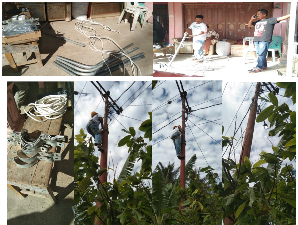
Gambar 5. Pemasangan Lampu Jalan Bersama Masyarakat
