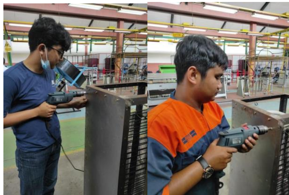
Gambar 9. Proses Pemasangan Plat Pada Rangka Pendingin
